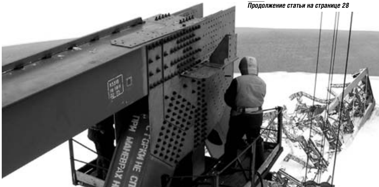
Фото 1. Проведение монтажных работ по сборке мостовых металлоконструкций с помощью фасонки и высокопрочных болтов
